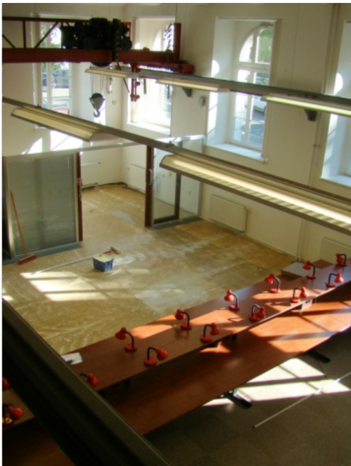
Pokládka koberců v Červené studovně
